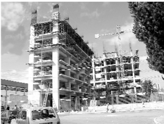
Avance de la obra a Marzo del 2003
