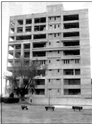
Avance de la obra a agosto de 2001
