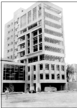
Avance de la obra a noviembre de 2001
